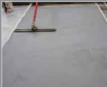
2. Lisciatura prima mano First coat smoothing
