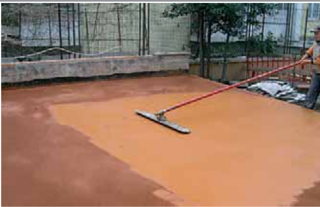
3. Lisciatura della superficie Smoothing of the surface
