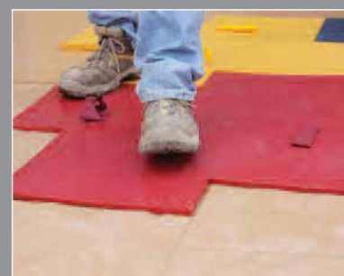
3. Stampaggio della superficie Surface stamping
