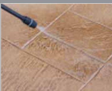
5. Applicazione dell'antichizzatore liquido Antique Liquid application
