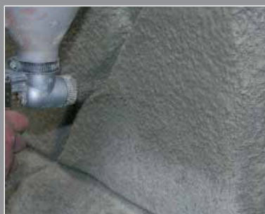
2. 2° mano Rockwall Rockwall 2° coat
