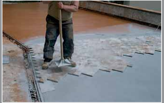
5. Stampaggio della superficie con stampi Stone Stamping the surface with Stone Stamps
