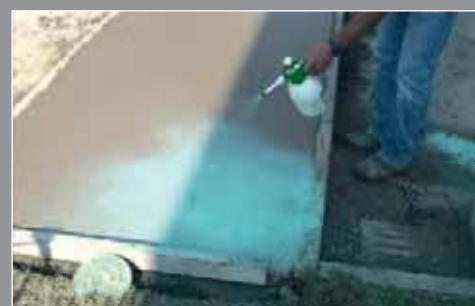
3. Applicazione del CSK Disattivante CSK Disattivante Application
