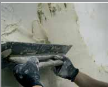
1. Applicazione di Decowall Decowall Application
