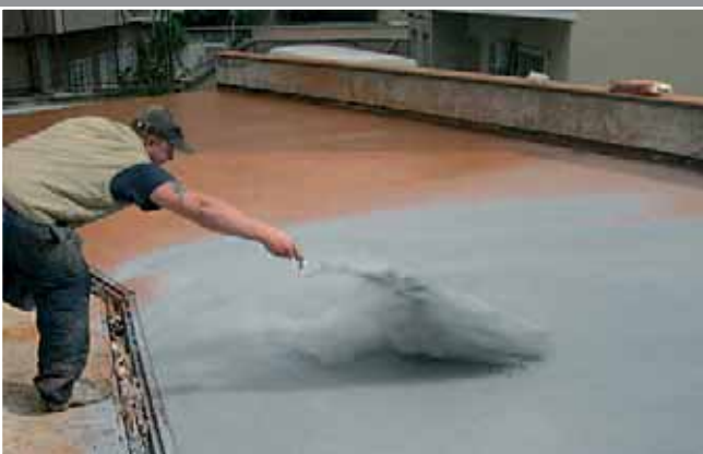
4. Applicazione di Stonart – distaccante in polvere Application of Stonart – release powder
