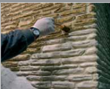
5. Colorazione con pennello Surface brush painting
