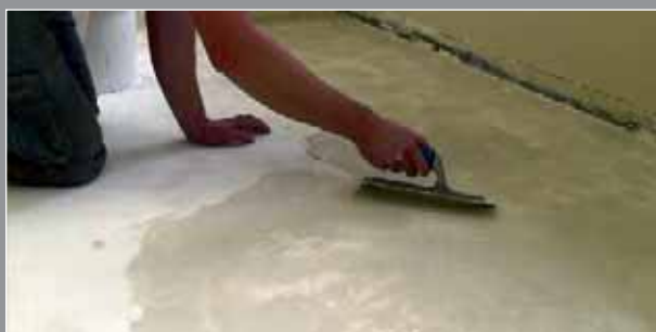
3. Applicazione Micro Topping S Micro Topping S application
