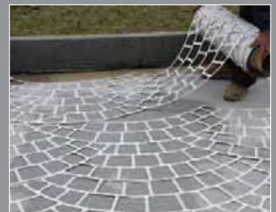
3. Applicazione dello stencil Stencil Application
