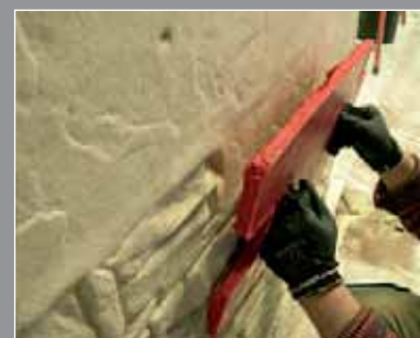
3. Stampaggio della superficie Stamping of the surface
