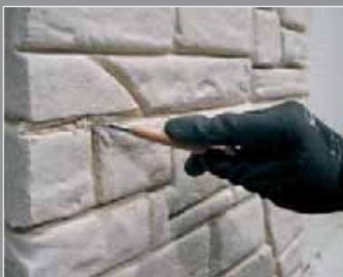
4. Rifinitura della superficie Surface finishing
