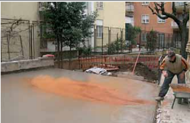
2. Applicazione di Hardstone – indurente colorato Application of Hardstone – color hardener
