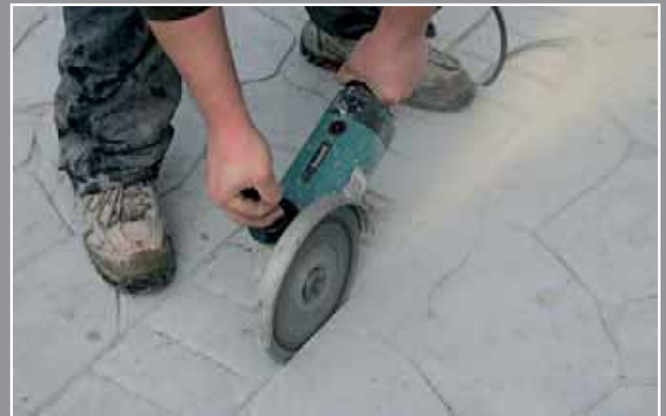
6. Esecuzione di giunti Joints execution
