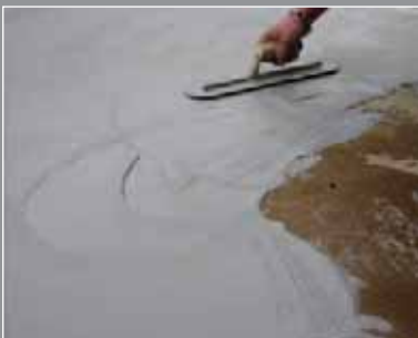
1. Applicazione prima mano Bond coat application
