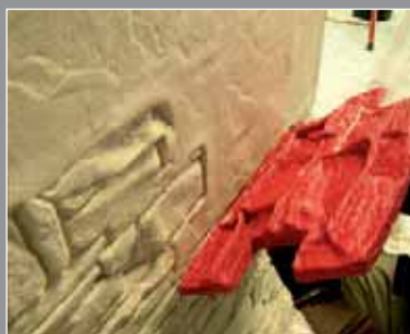
2. Stampaggio della superficie Stamping of the surface
