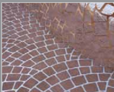
5. Rimozione dello Stencil Stencil removal
