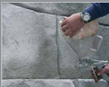
1. 1° mano Rockwall Rockwall 1° coat
