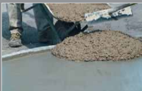
1. Stesura impasto Chromostone Chromostone mix pouring
