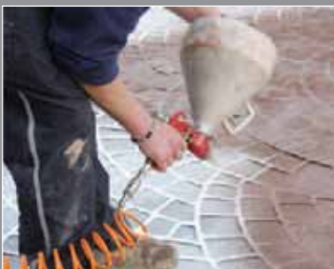
4. Applicazione Stone Spray Decotop Spray application
