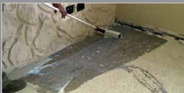
1. Applicazione Primer MT Primer MT Application
