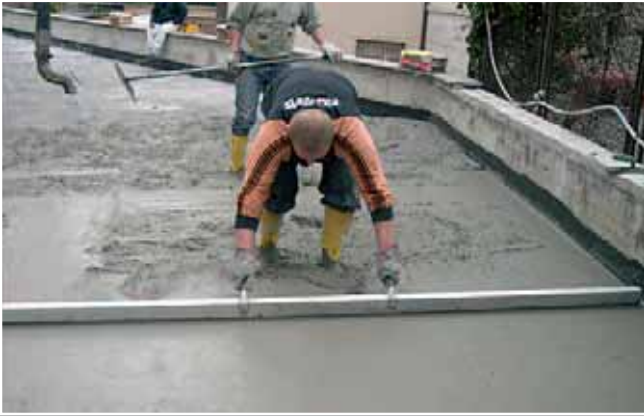
1. Getto e livellamento del calcestruzzo Spreading of the concrete
