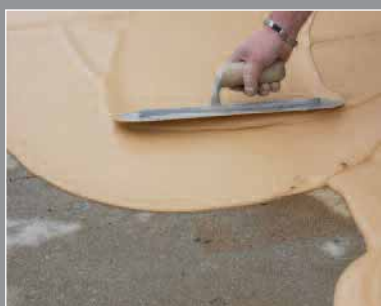
1. Applicazione prodotto Bond coat application
