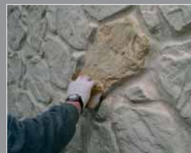
6. Colorazione con spugna Surface sponge painting
