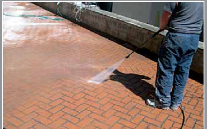
7. Lavaggio della superficie Washing of the surface
