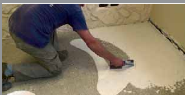
2. Applicazione Micro Topping R Micro Topping R application
