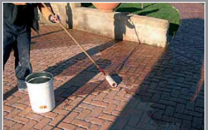
8. Applicazione della resina Sealfloor 100 Application of sealer Sealfloor 100
